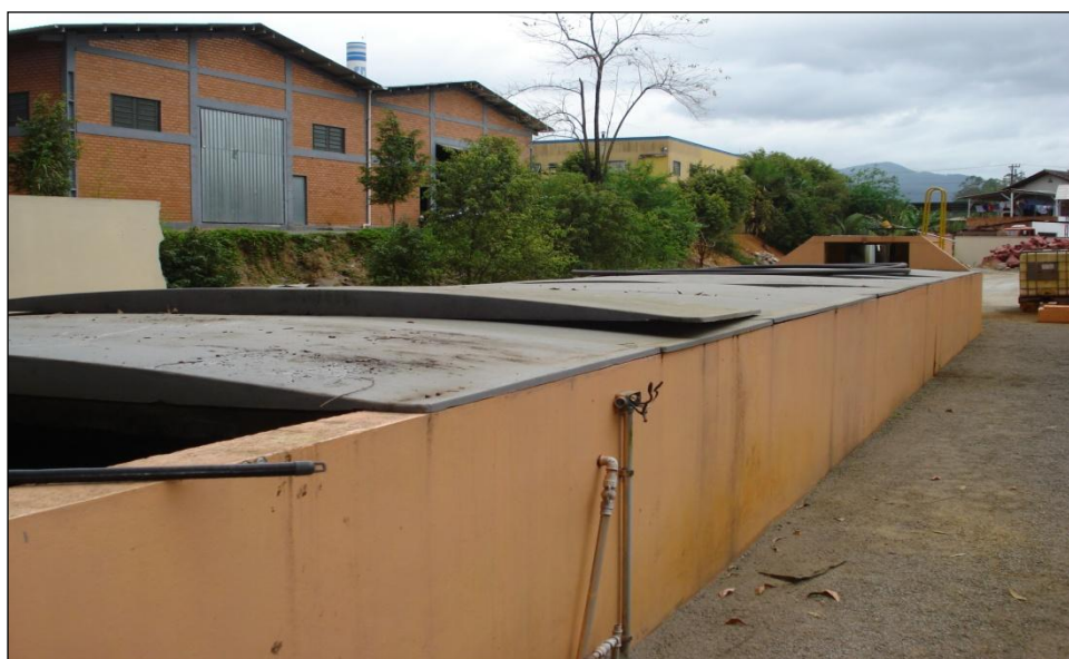
Figura 70: ETE Água Verde: Tanque de Contato para Desinfecção do Efluente.
