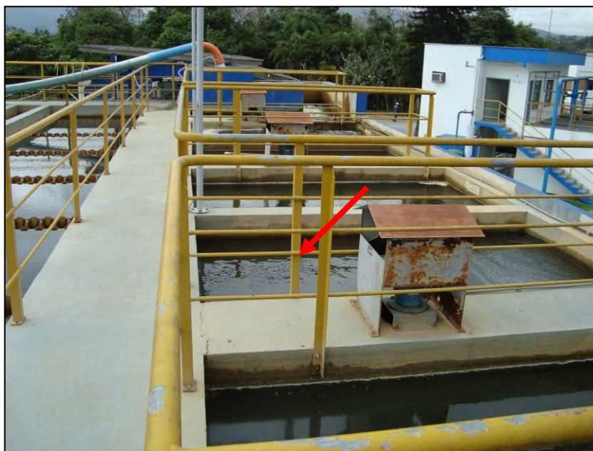
Figura 13: Floculadores Mecânicos ETA II.
