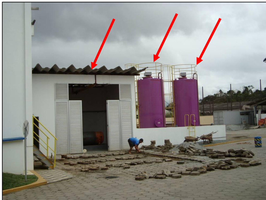
Figura 19: Tanques de Geocálcio, PAC e Casa dos Cilindros de Cloro Gás.
