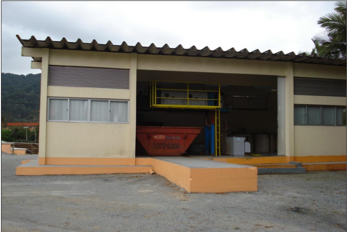
Figura 76: ETE Figueira – Unidade de Desaguamento do Lodo com Filtro Prensa.
