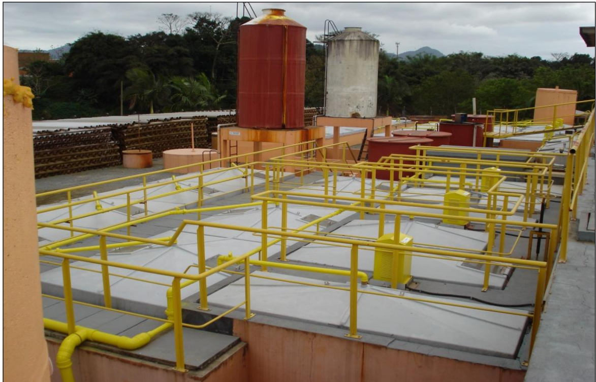
Figura 74: ETE Figueira – Tratamento Terciário: Físico-Químico, Floculadores e Decantador de Alta Taxa (2 Módulos).
