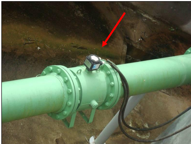
Figura 20: Macromedidor Eletromagnético do R4.
