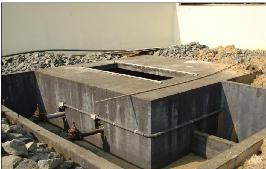
Figura 78: ETE Nereu: Estação Elevatória Final de Esgoto Bruto.
