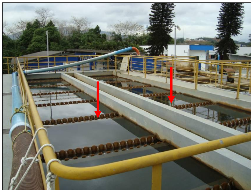
Figura 14: Decantador do Tipo Alta Taxa ETA II.
