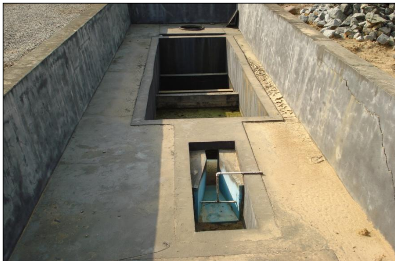
Figura 83: ETE Nereu – Tanque de Contato, Medição Final da Vazão e Desinfecção do Efluente.
