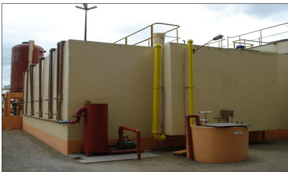
Figura 67: ETE Água Verde – Tratamento Terciário: Físico-Químico Floculadores e Decantadores.
