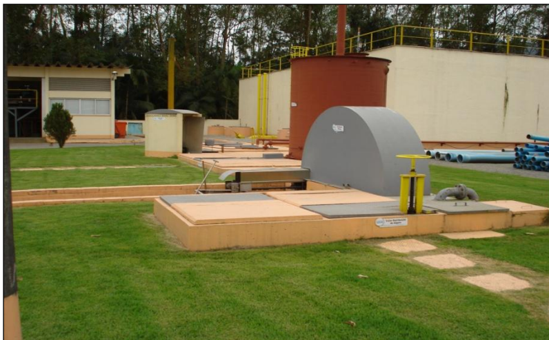
Figura 65: ETE Água Verde – Tratamento Preliminar – Gradeamento, Caixa de Areia, Calha Parshall e Estação de Recalque de Esgoto Bruto.
