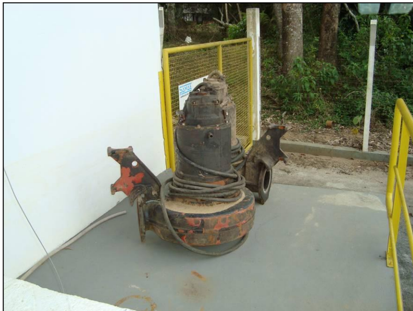
Figura 11: Bomba Submersa Reserva Localizada ao Lado do Poço de Captação.
