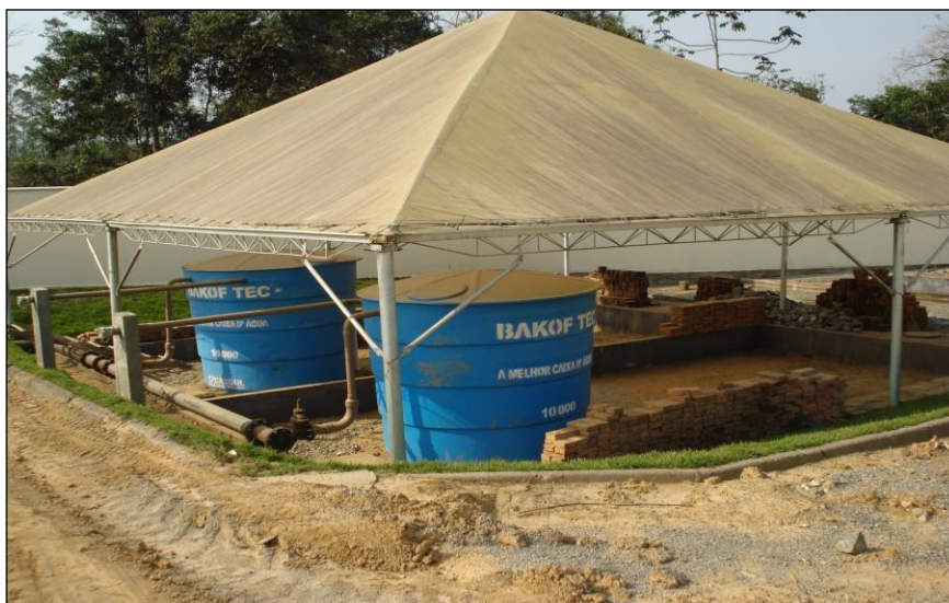
Figura 82: ETE Nereu – Adensadores de Lodo.
