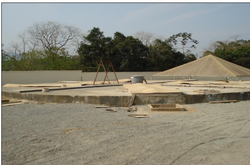
Figura 81: ETE Nereu – Reatores Aeróbios Sequenciais por Batelada.
