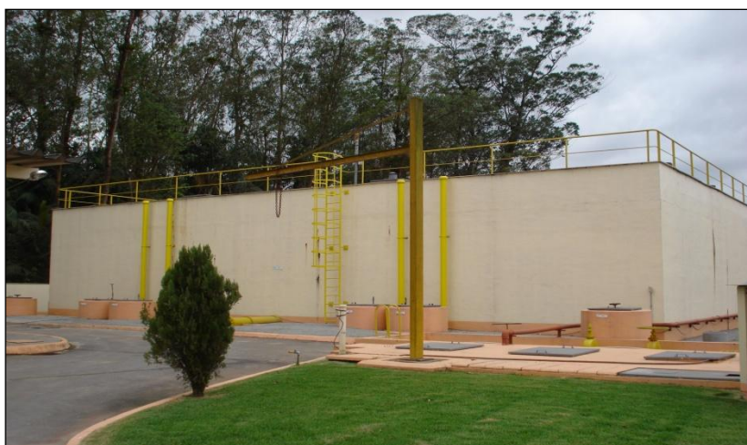
Figura 66: ETE Água Verde – Tratamento Secundário Reator Anaeróbico Tipo RALF.
