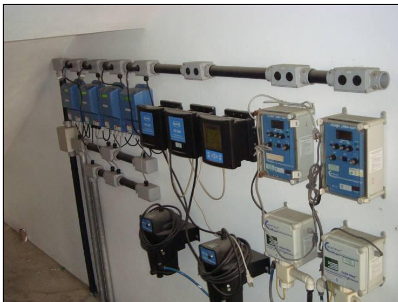
Figura 23: Equipamentos de Medição de Vazão pH e Turbidez com Sinal 4 a 20 \mu A.
