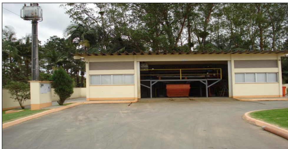
Figura 69: ETE Água Verde: Unidade de Desaguamento do Lodo com Filtro Prensa.
