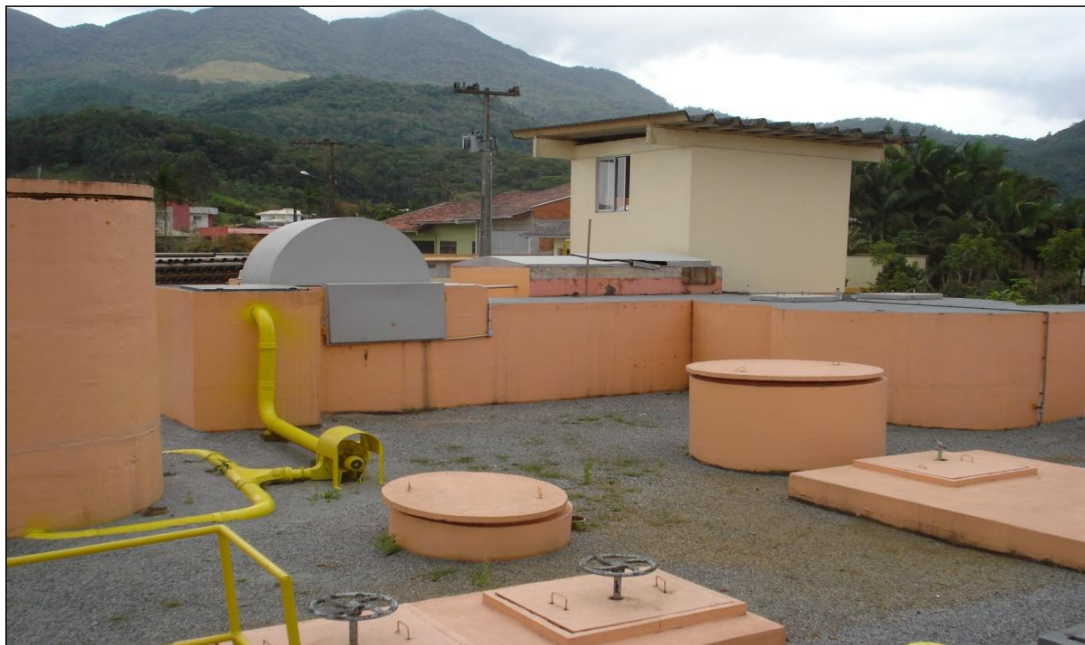
Figura 72: ETE Figueira – Unidades do Tratamento Preliminar: Gradeamento, Desarenação, Medição da Vazão de Esgoto Bruto e Caixa Distribuidora de Vazão.
