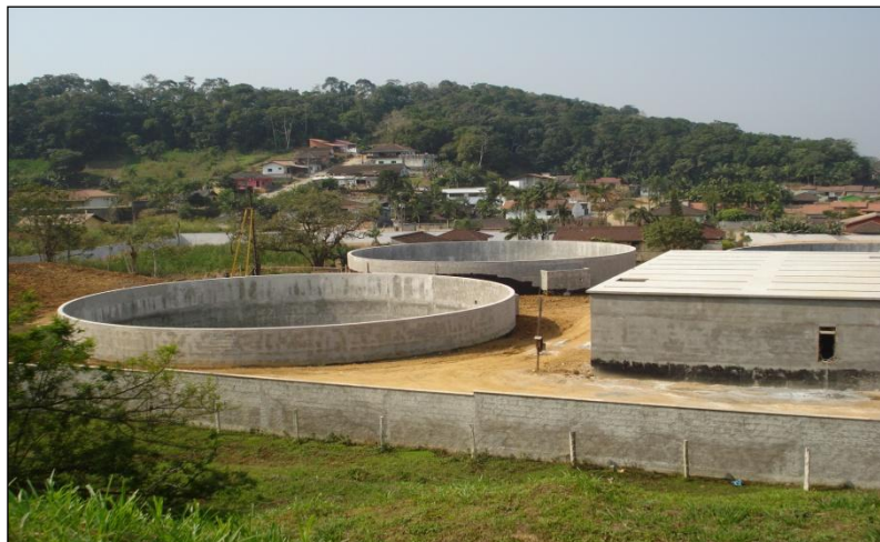
Figura 87: Reatores Aeróbios Tipo Seqüencial por Batelada.
