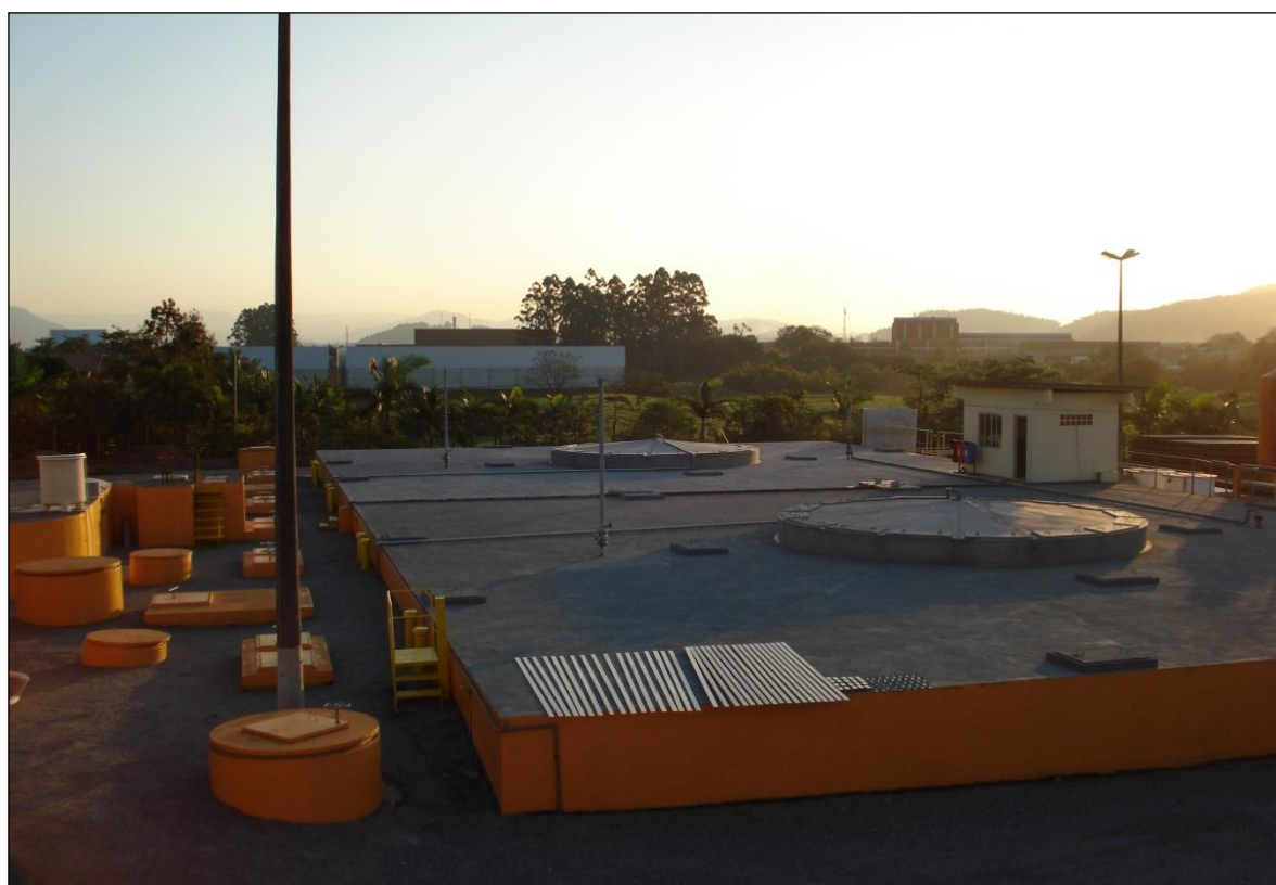
Figura 73: ETE Figueira – Tratamento Secundário: Reator Anaeróbico de Leito Fluidificante (2 Módulos).
