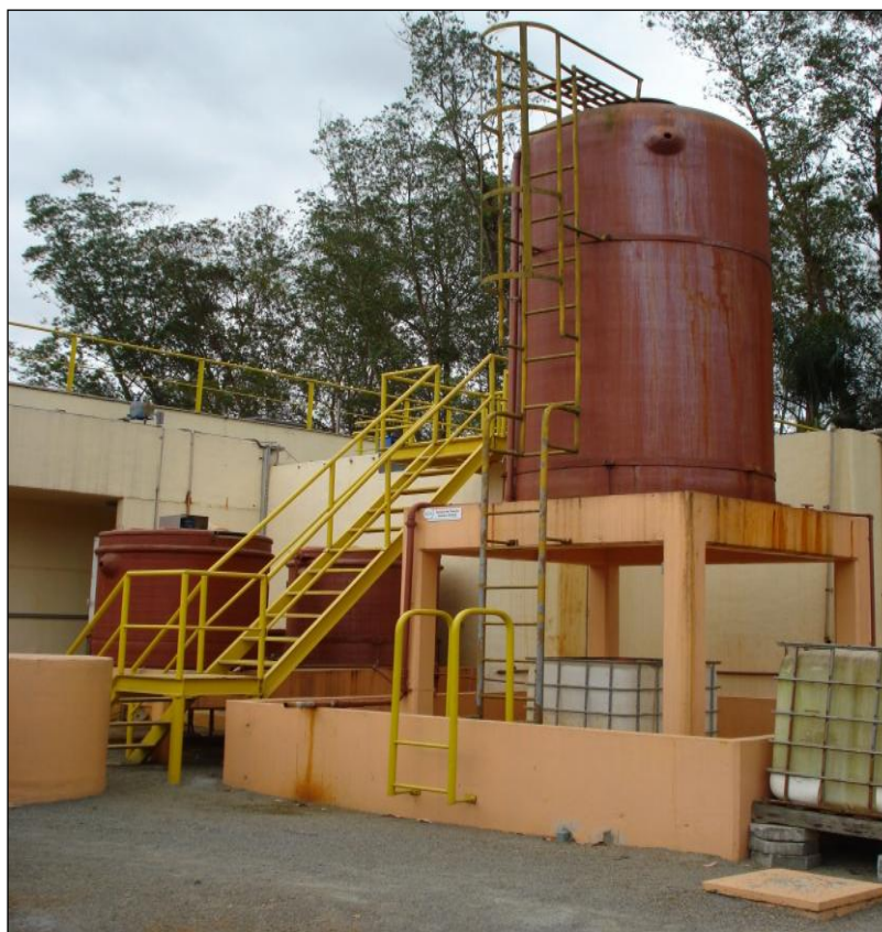
Figura 71: Tanques de Produtos Químicos (cloreto férrico, hipoclorito de sódio e anti-espumante).
