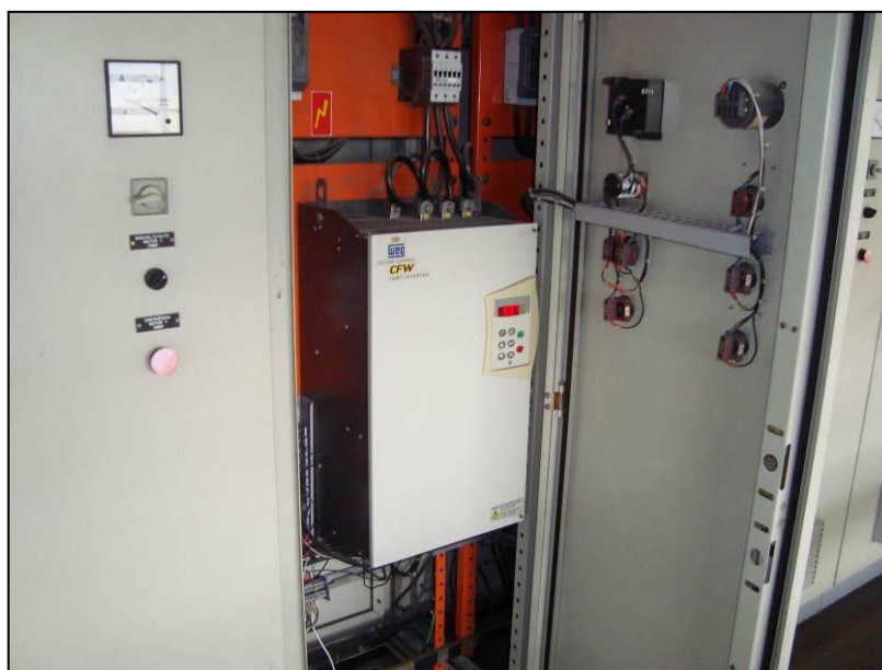
Figura 10: Painel Elétrico com Inversor de Frequência de uma das Bombas da Captação de Água Bruta.
