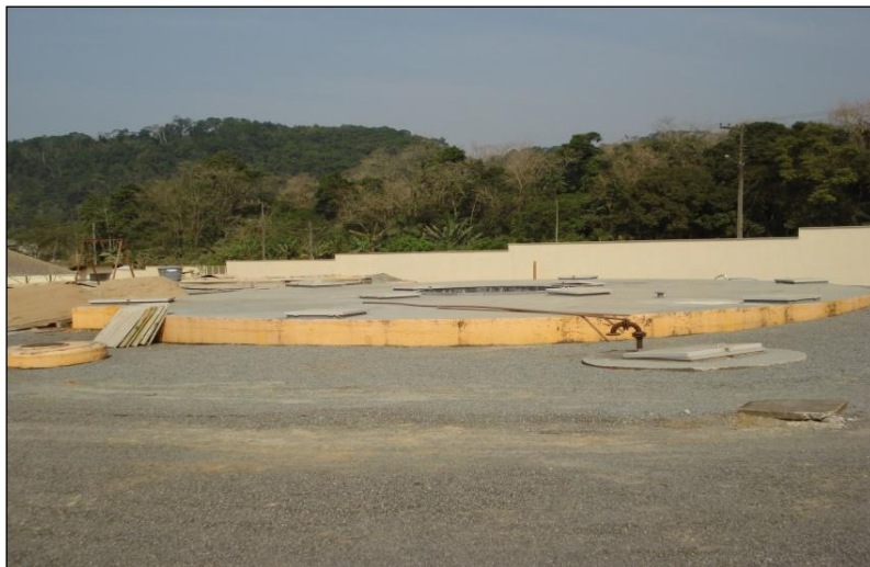
Figura 80: ETE Nereu – Reator Anaeróbico Tipo RALF.
